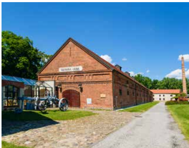
↑ Ośrodek Kultury Leśnej w Gotuchowie, fot. arch. obiektu
